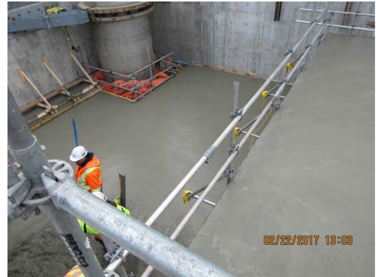
Roof Concrete Pour
