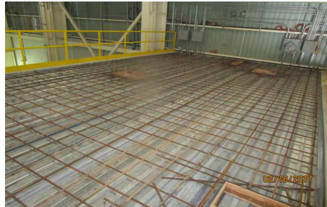
Electrical Room – Roof Pour
